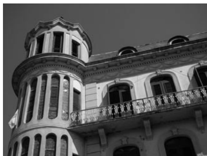
Fig. 4. Edificio Morey, San Pedro de Macorís.
