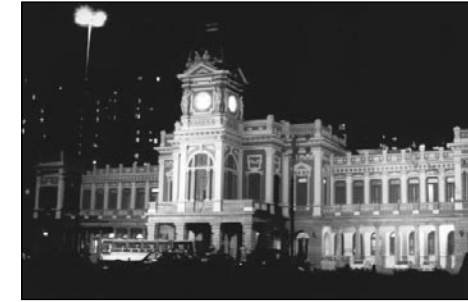
Fig. 10: Edificio de la estación central
