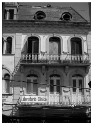
Fig. 3. Edificio Morey, San Pedro de Macorís.
