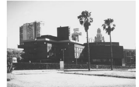
F3 – Vista desde la calle Camacú
