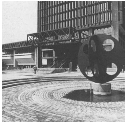
Fig. 8: Edificio UNCTAD acceso posterior torre
