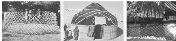
Fig. 4: Proceso de montaje de la estructura plegable, vista general y vista interna de la "Yurta", Asia Central
