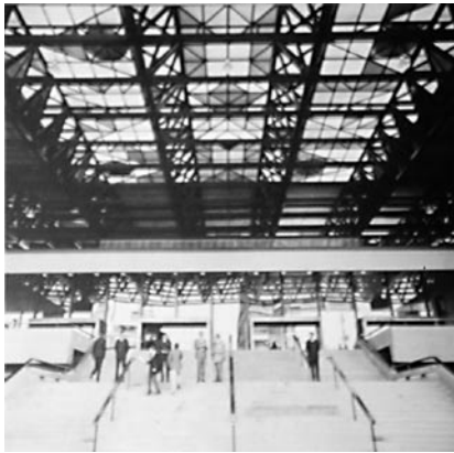
Fig. 7: Edificio UNCTAD claraboya acceso
