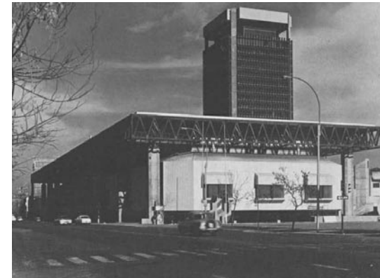
Fig. 3: Edificio UNCTAD frente
