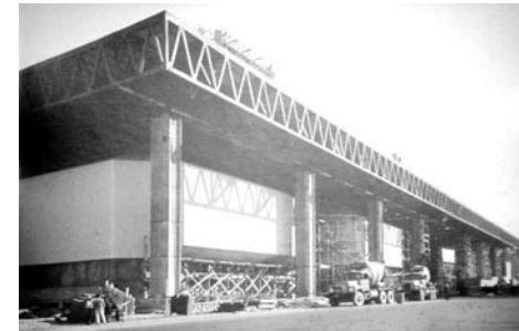
Fig. 4: Edificio UNCTAD frente
