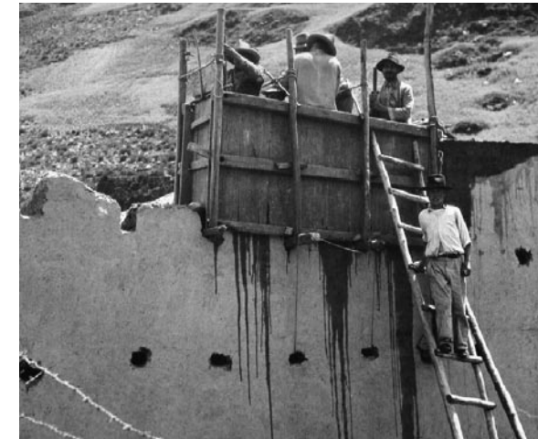
Fig. 3: Tapia. Fuente: GASPARINI, Graziano y MARGOLIES, Luise. Arquitectura Popular de Venezuela. Caracas: Armitano Editor.1986. Pág. 123
