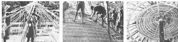
Fig. 3: Proceso de tejido del "Sadamo" conformada por una trama y Urdimbre de bambú y vista de la cumbre del cobijo
